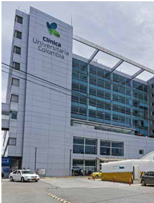
En el parqueadero de la Clínica Universitaria Colombia se levantó una carpa de cuatro metros de altura como una estructura provisional.
